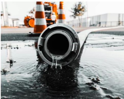
Vazamento (Data Leak)
